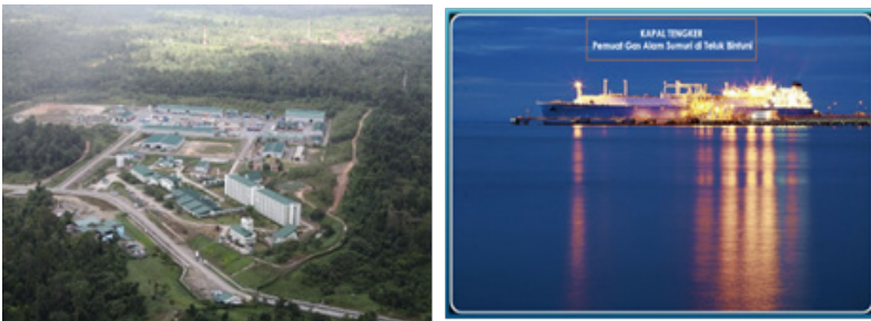
Gambar 01 lokasi pengelolaan Gas alam di Teluk Bintuni Papua Barat
